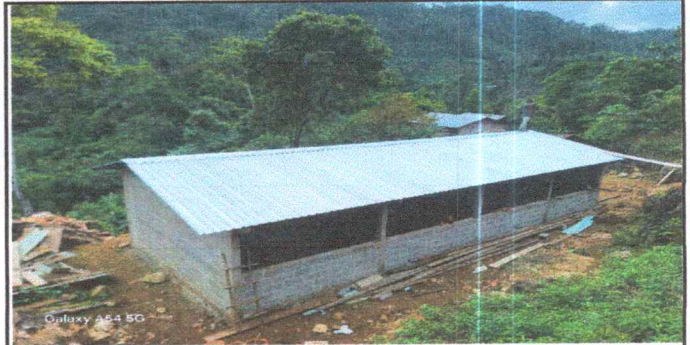
Foto Instalada 100% la cubierta de lamina troquelada calibre 26.
