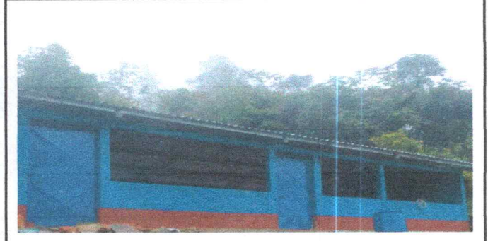
Foto 4: pintura en muros interior y exterior.
